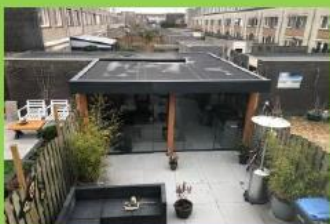
Douglas overkapping / EPDM dak + isolatie
