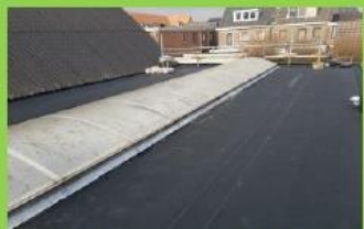
EPDM dak met lichtstraat
